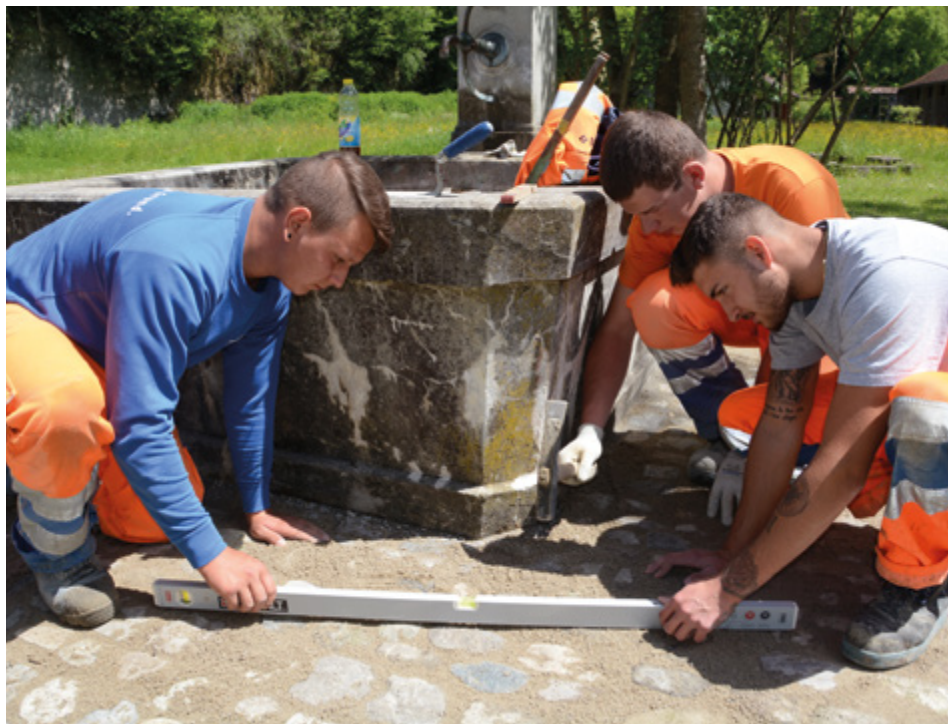
Die drei Verkehrswegebauer-Lernenden Michael Peterhans, Weinfelden; Manuel Lattmann, Balterswil, und Luca Recine, Frauenfeld (von links) erstellen eine Brunneinfassung mit Wildpflastersteinen.
